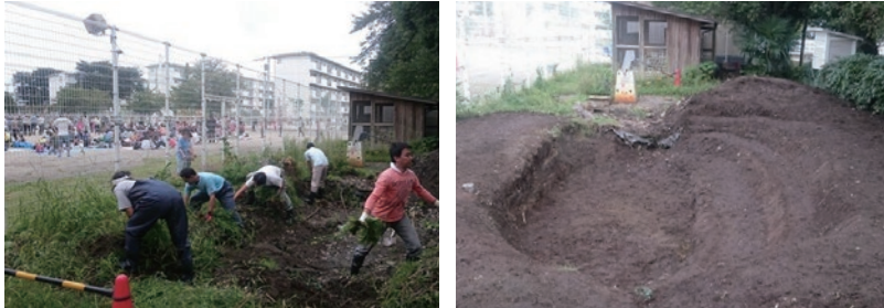
夏休みをはさみ、草が茂っていました。 作業後、段差ができました。
