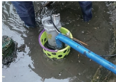
排水は直接下水に流します。
