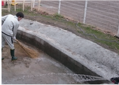
水抜き後清掃、水張りです。
