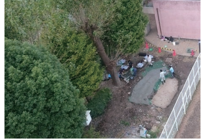
地上30メートルからの作業風景です。
