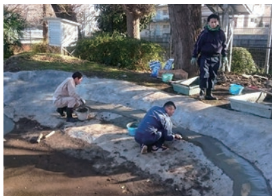
モルタルが徐々に崩れてくるので階段状の作り込みがなかなか難しい。
