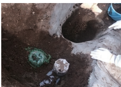
作業前、循環口と排水口の周りは土。
