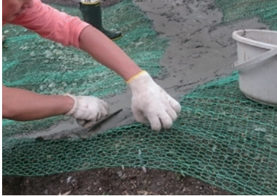
金網にコンクリートをのせいきます。
