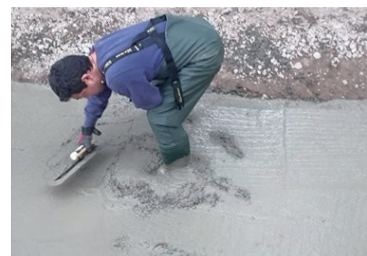
仕上げのならし作業中です。
