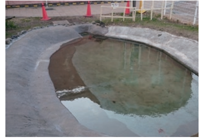
水位が下がり、漏れが発見されました。
