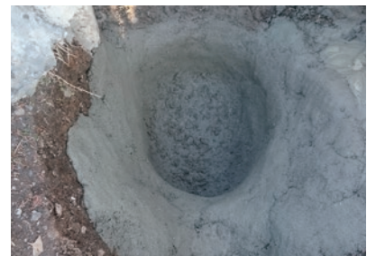
金網の上にコンクリートを重ねて、排水ポンプ挿入口を作りました。
