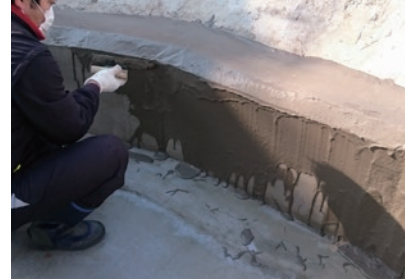
外側からモルタルを塗っていきます。
